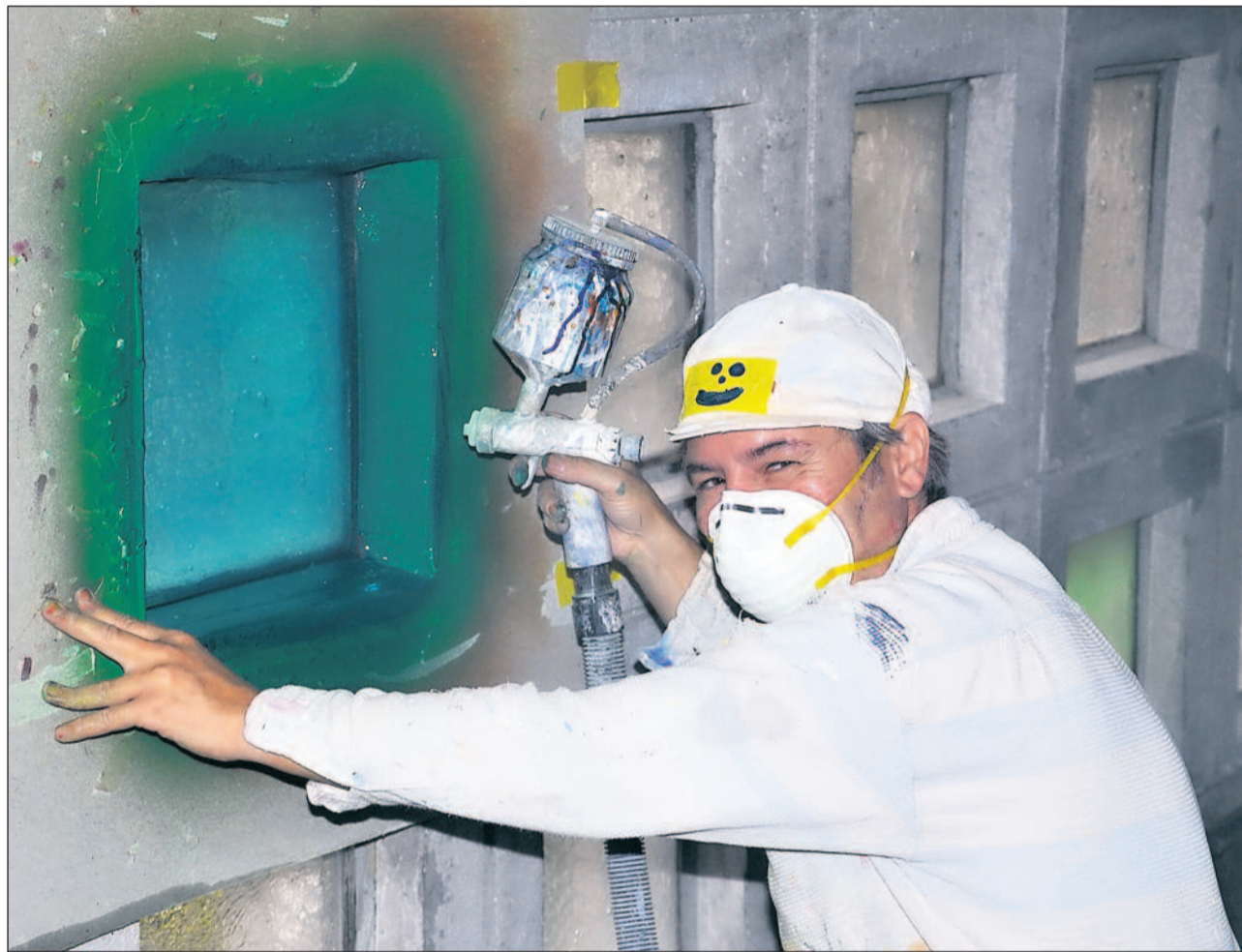
Bernhard Winkler braucht viel Gefühl für die Farben, um die Glasfenster transparent einzufärben. Foto: ben.
